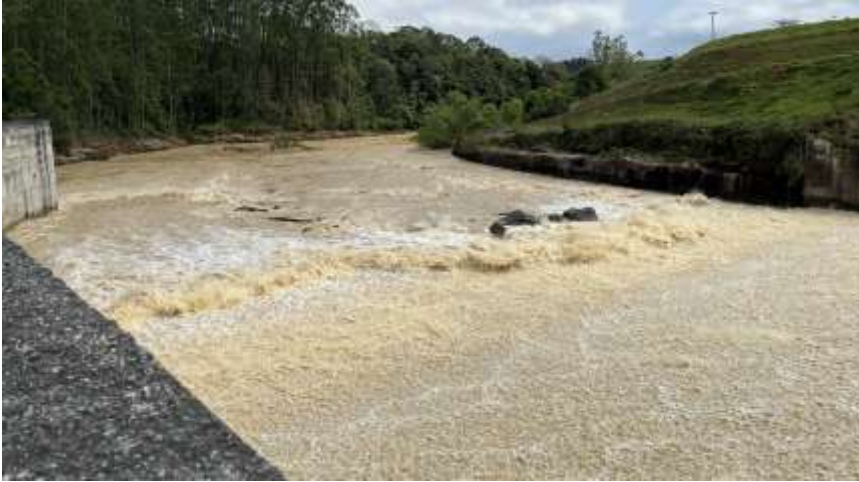
Foto N.º 21: Margem Esquerda - Jusante da barragem Vertedouro de soleira livre - Vista do canal de fuga
