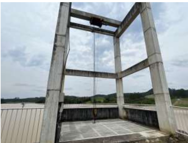
Foto N.º 31: Montante da barragem - Margem Direita Pórtico da talha do túnel - Canal extravasor
