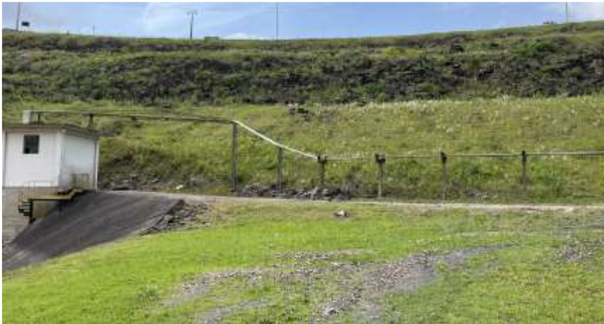
Foto N.º 06: Margem Esquerda - Jusante da barragem Talude de enrocamento
