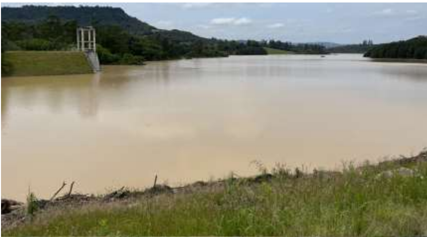
Foto N.º 26: Montante da barragem Vista da Margem Esquerda
