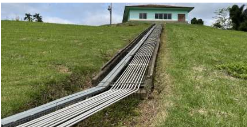
Foto N.º 04: Margem Esquerda - Talude de jusante da barragem Casa de Operação
