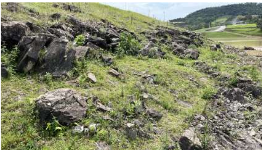
Foto N.º 28: Montante da barragem - Margem Esquerda Vista do talude de enrocamento na direção da ombreira direita
