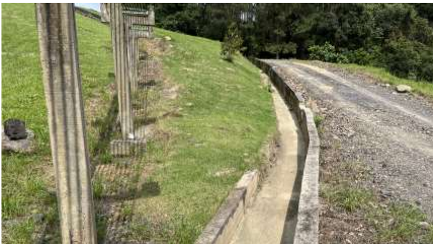
Foto N.º 07: Margem Esquerda - Jusante da barragem Estruturas em concreto armado - Apoio da tubulação de acionamento das comportas
