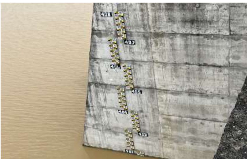
Foto N.º 32: Montante da barragem - Margem Direita Régua na lateral da estrutura do Pórtico da talha
