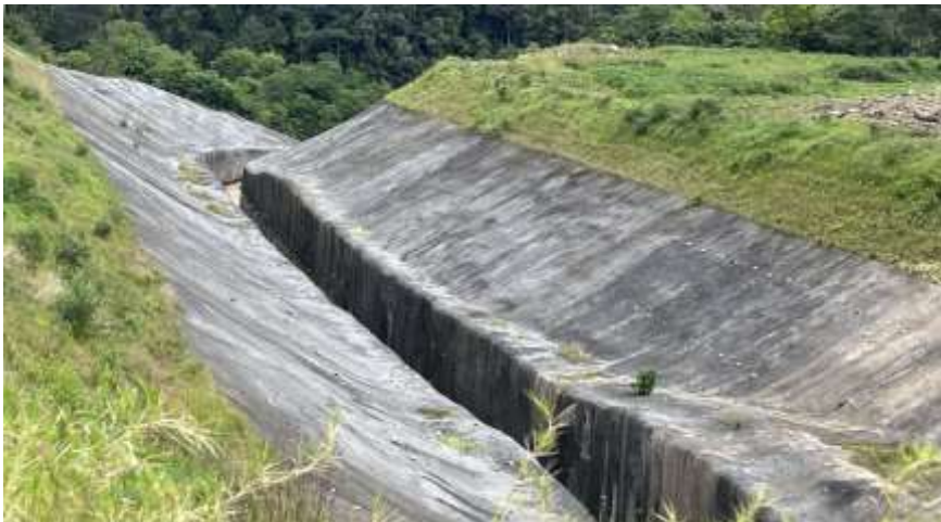
Foto N.º 33: Jusante da barragem - Margem Direita Canal extravasor
