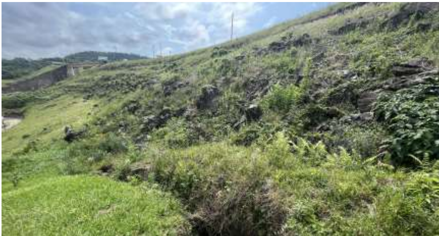
Foto N.º 03: Margem Esquerda - Talude de jusante da barragem
