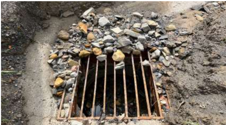
Foto N.º 09: Margem Esquerda - Jusante da barragem Sistema de drenagem do pé da barragem Boca de lobo de escoamento de águas pluviais
