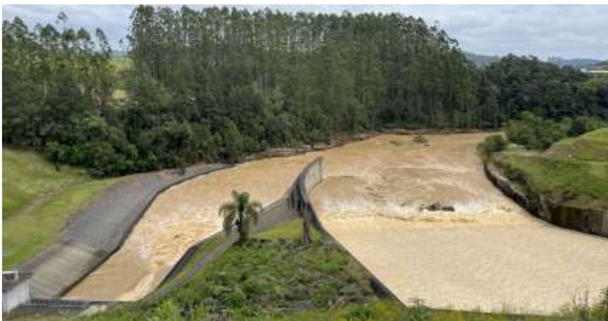
Foto N.º 22: Jusante da barragem - Vista geral do canal de fuga Encontro da vazão das comportas com a vazão do vertedouro
