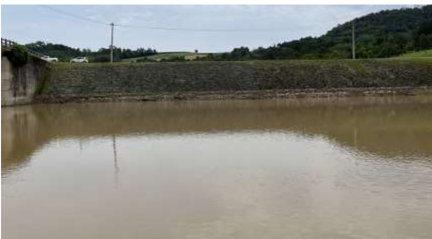
Foto N.º 29: Montante da barragem - Margem Direita Vista do talude com proteção de enrocamento
