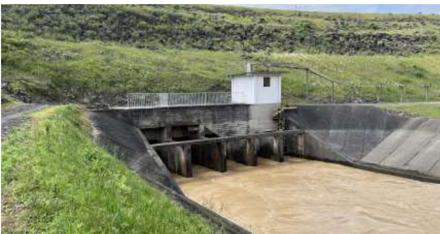
Foto N.º 17: Margem Esquerda - Jusante da barragem Sistema de comportas hidráulicas
