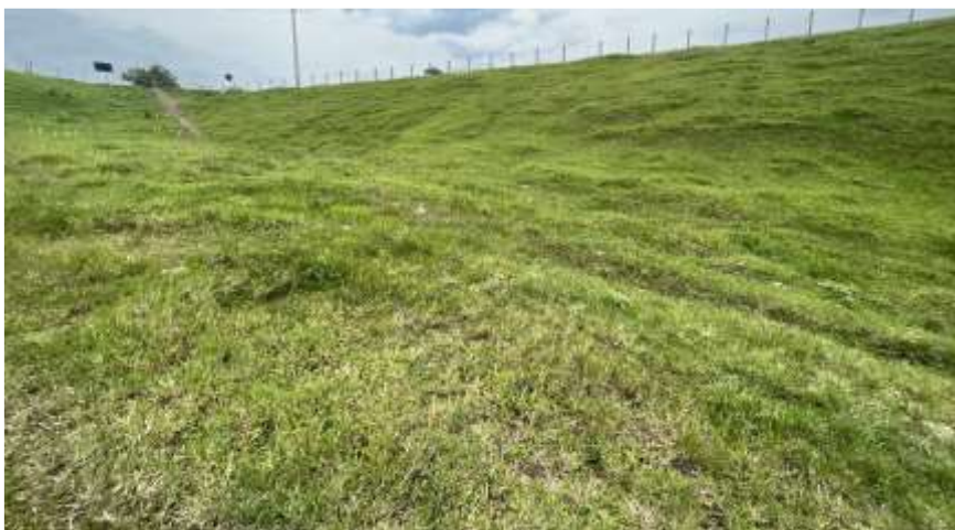
Foto N.º 34: Jusante da barragem - Margem Direita Talude de grama na ombreira direita - excelente estado de conservação
