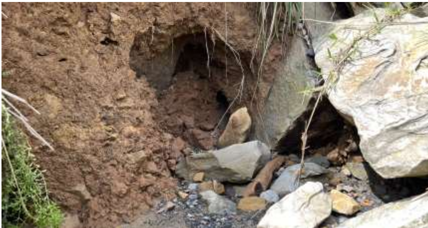
Foto N.º 12: Margem Esquerda - Jusante da barragem Valeta de escoamento de águas pluviais - Processo erosivo anterior (Detalhe Ampliado)
