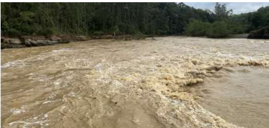
Foto N.º 23: Jusante da barragem - Canal de fuga Encontro da vazão das comportas com a vazão do vertedouro
