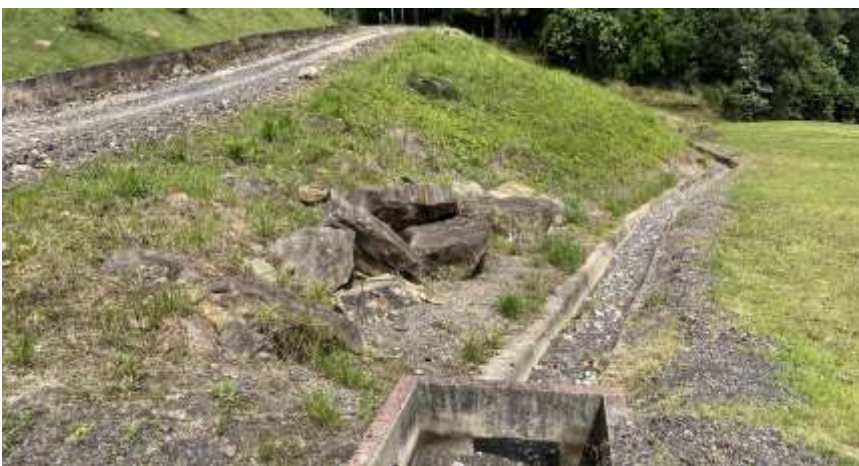
Foto N.º 08: Margem Esquerda - Jusante da barragem Captação de águas pluviais - canaleta de drenagem e caixa de ligação
