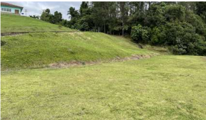
Foto N.º 16: Margem Esquerda – Taludes de grama de Jusante da barragem Excelente estado de conservação
