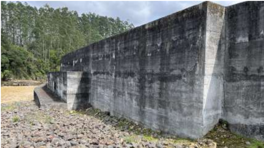
Foto N.º 24: Jusante da barragem - Vista do Muro de Concreto Separa as vazões do sistema de comportas e do vertedouro
