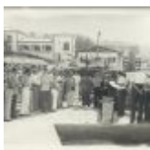
Construção da sede do Conselho em
