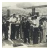
Construção da sede do Conselho em Florianópolis
