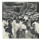
Construção da sede do Conselho em Florianópolis
